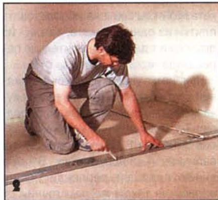
2 С помощью ровной рейки на полу проводят базовые линии, обозначая положение первой плитки.
