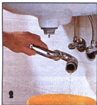
1 Открутив накидную гайку старого сифона, выливают воду из колена.
