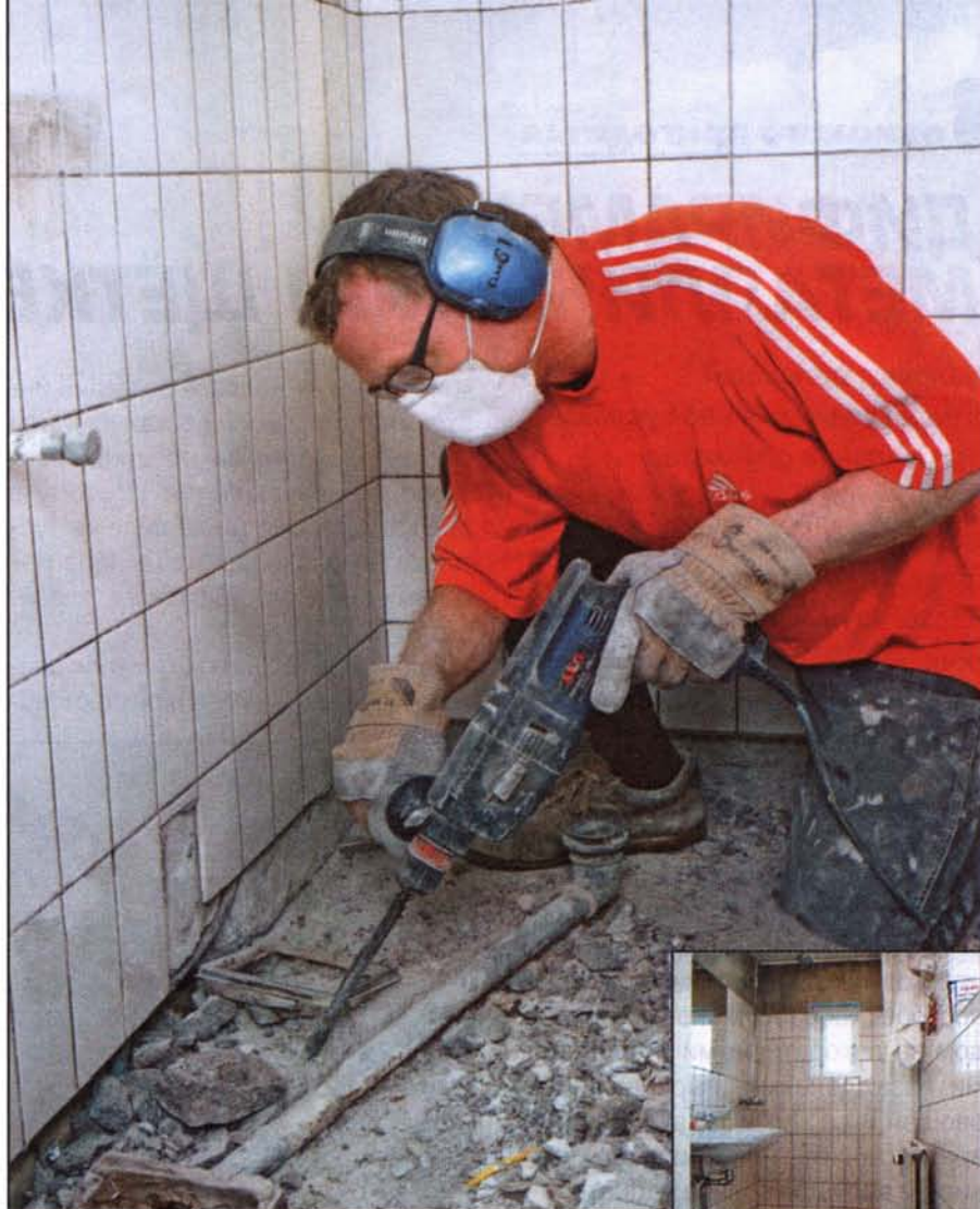
Только вскрыв покрытие пола душевой, можно понять, что старые трубы доживали свои последние дни.
