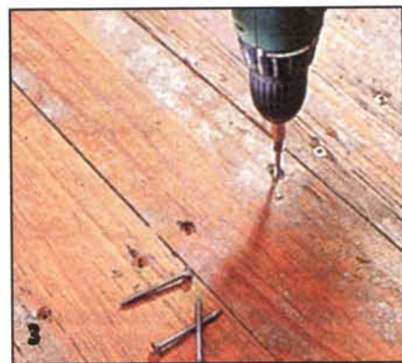
3 Доски крепят шурупами к лагам (по два шурупа на каждую лагу).
