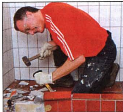
Старый бордюр душевой кабины был слишком высоким. Поэтому его пришлось срубить. Для избежания травмирования глаз разлетающимися острыми осколками кафельной плитки работать следует в защитных очках.
