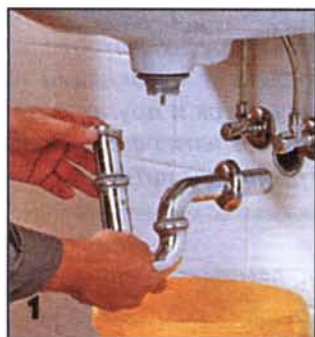
1 Открутив накидную гайку старого сифона, выливают воду из колена.
