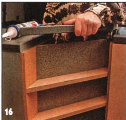
16 Плиты из серого гранита просто кладут сверху и фиксируют на подстолье силиконовым герметиком.
