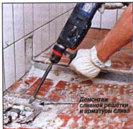
Старый бордюр душевой кабины был слишком высоким. Поэтому его пришлось срубить. Для избежания травмирования глаз разлетающимися острыми осколками кафельной плитки работать следует в защитных очках.
