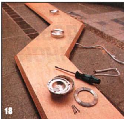
18 К собранному несущему элементу освещения крепят светильники. Провода прокладывают скрыто с противоположной стороны.
