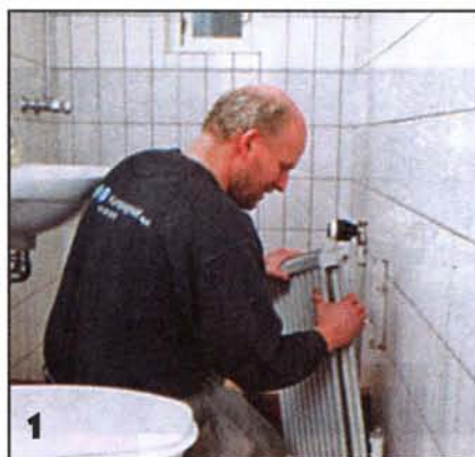
До начала демонтажа батарей отопления и другой сантехники нужно перекрыть подачу воды в систему отопления и поставить краны на входе и выходе трубопровода ванной.
