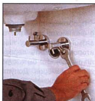
6 При установке угловых вентилях, чтобы не повредить резьбу, на выступающие патрубки навинчивают гайки.
