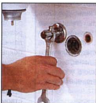
3 Перекрыв подачу воды, отвинчивают гайки подводок, демонтируют арматуру и оба угловых вентиля.
