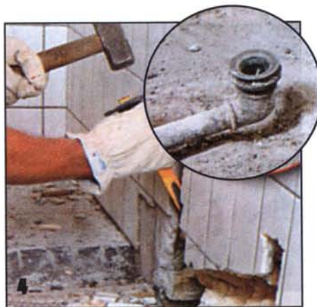
Водопроводные трубы, вмонтированные в стены, вырубали зубилом. Их надо обязательно менять, так как за годы эксплуатации они сильно забились известковыми отложениями.
