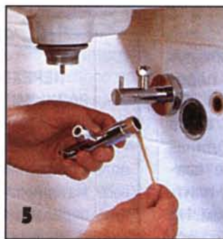
5 Удалив с резьбы угловых вентилях старое уплотнение, если вентили не имеют встроенных уплотнительных прокладок, обматывают их резьбу трепаным льном или уплотнительной лентой.
