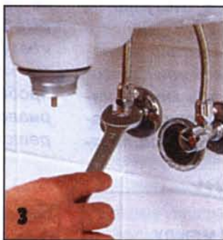
3 Перекрыв подачу воды, отвинчивают гайки подводок, демонтируют арматуру и оба угловых вентиля.
