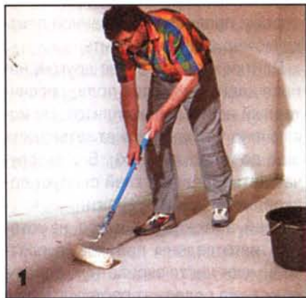
1 За день до укладки пробкового паркета основу грунтуют.
