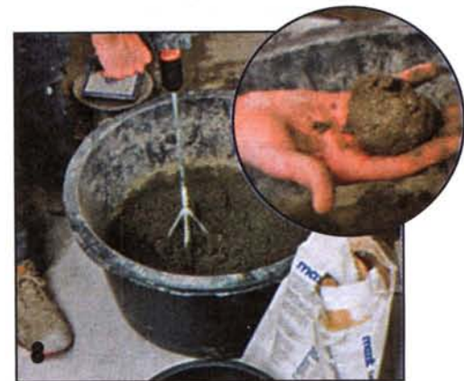
В сухую смесь надо добавить только воду. Полученный раствор удобнее замешивать весёлкой, вставленной в электродрель. Он должен быть размешан до однородного сметанообразного состояния.
