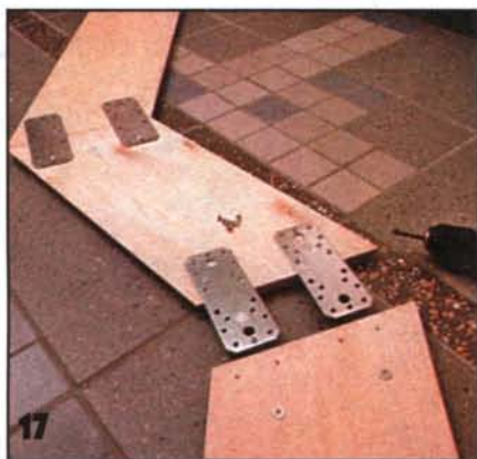
17 Три доски для карниза со встроенными потолочными светильниками запиливают на скос и соединяют друг с другом, чтобы получившийся элемент повторял форму стола.
